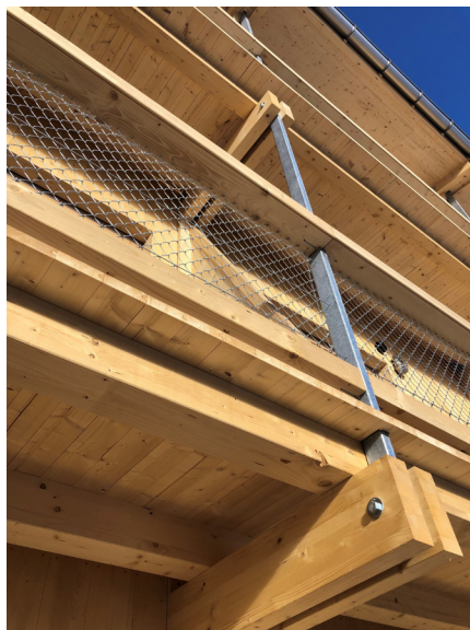
Die Balkone sind an senkrechten Stangen aufgehängt.
