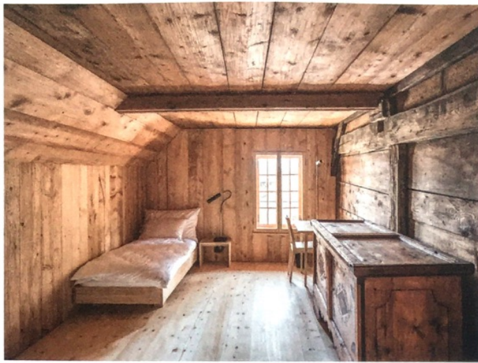
Unbekümmert im Normenkorsett: Die Zimmerleute haben die Balkendecke angehoben, die abgeschliffenen Bodendielen an die Wand montiert und am Boden neue Tannenbretter verlegt. Jedes Zimmer ist nun ein schallgedämmter Brandabschnitt.
