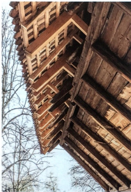
So einfach, wie die Handwerker einst die Rafen über den Kammeranbau spreizten, stützen neue Pfosten das gedämmte Dach von den Pfetten ab.
