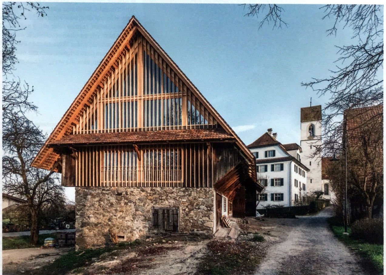
Flächen statt Löcher: Vor der fast vollverglasten Giebelfassade sorgen Holzlamellen für Ruhe und Einheit.
